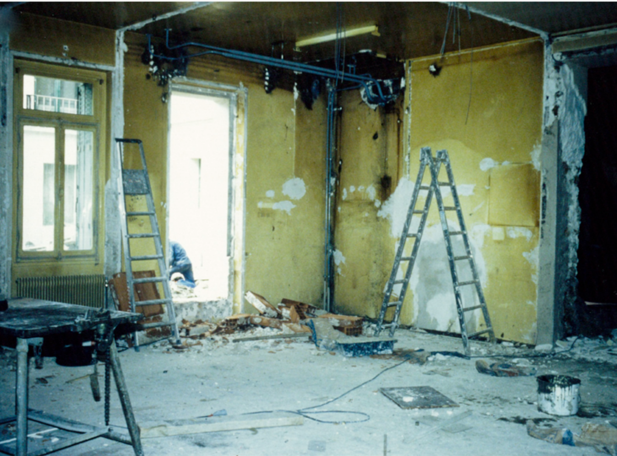
Obras de restauración Autor desconocido 1985 Archivo Histórico del Colegio de España
