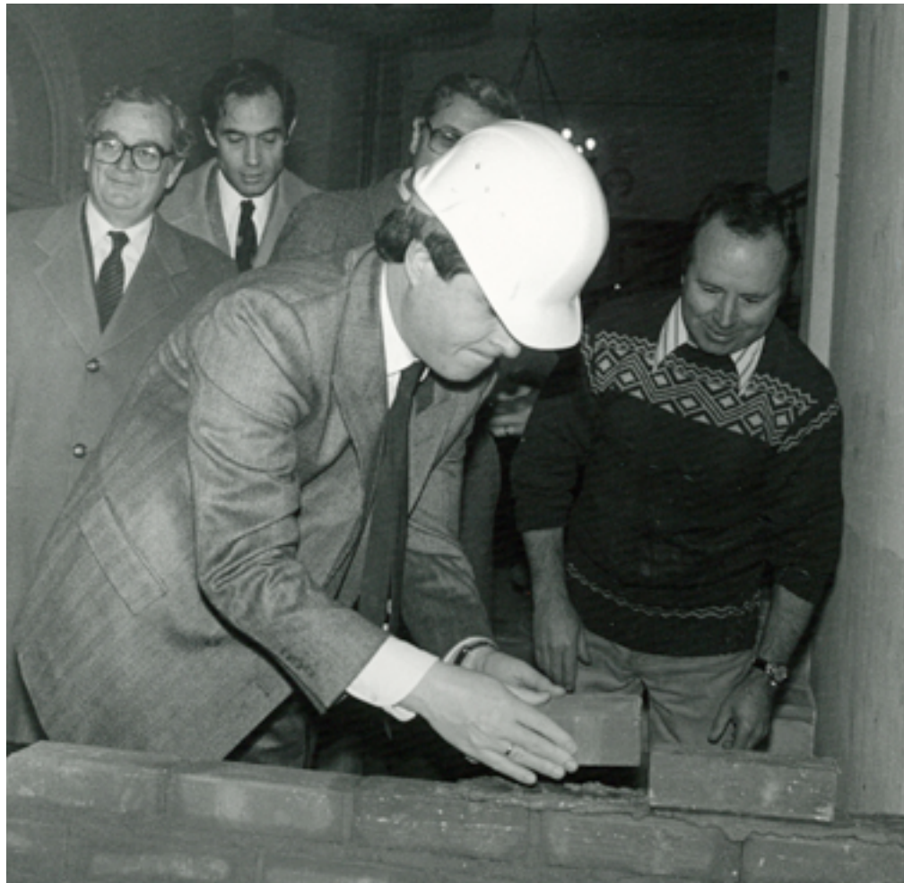
José Antonio Maravall pose la première pierre des travaux de rénovation du Colegio de España
